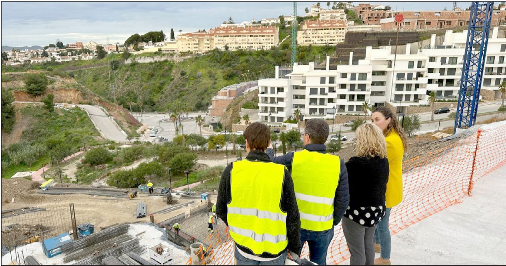
La alcaldesa, Ana Mula, y la edil Rocío Arriaga observan el avance de las Viviendas de Apoyo Municipal.
