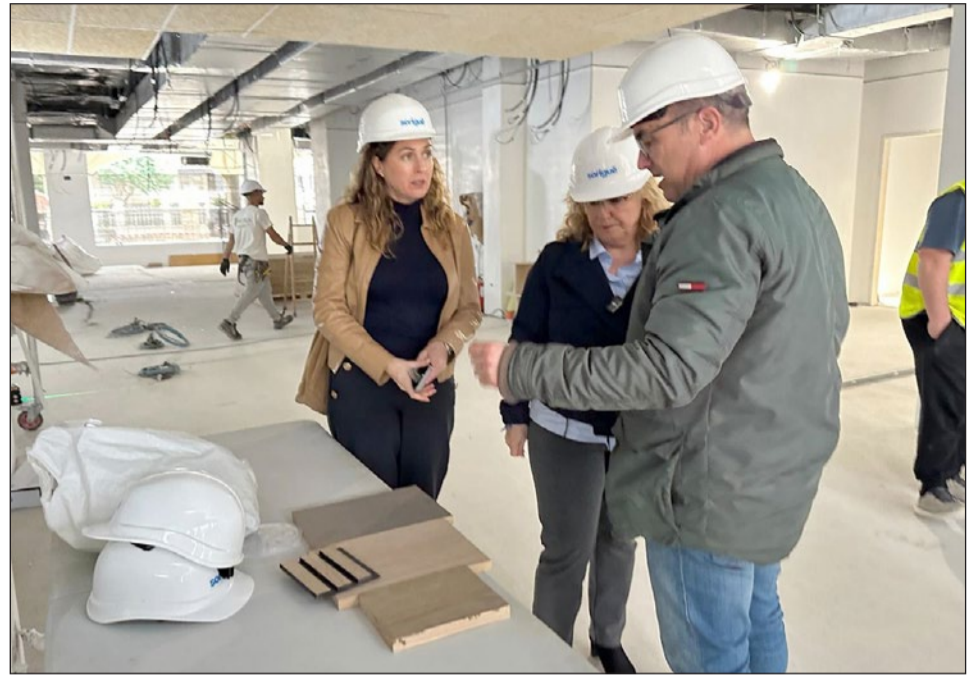
La alcaldesa, Ana Mula, ayer, durante la visita a los trabajos de construcción de estas nuevas instalaciones.
