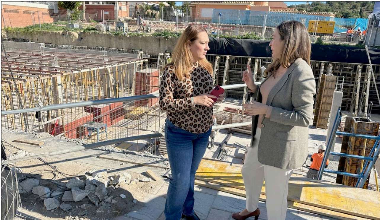
Las ediles Rocío Arriaga y Rosa Ana Bravo durante la visita a los trabajos que han superado ya el 10 por ciento de su ejecución.
