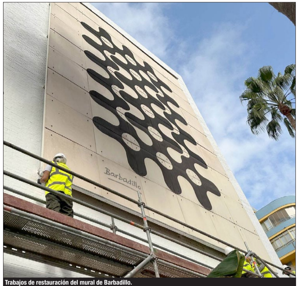
Trabajos de restauración del mural de Barbadillo.
