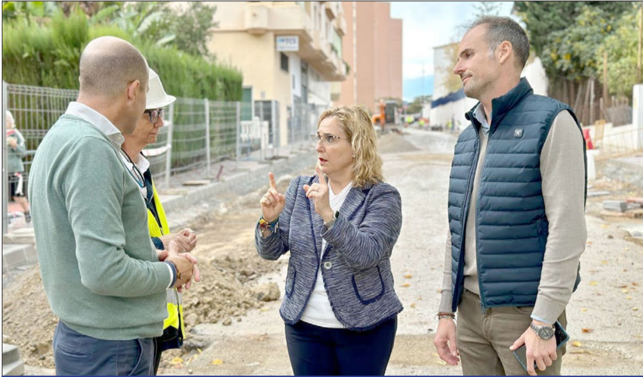
La alcaldesa, Ana Mula, dialoga con un operario durante su visita a las obras que están desarrollando en la calle Feria de Abril.
