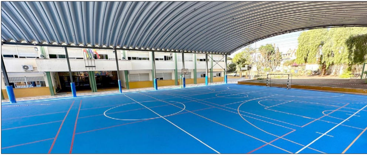
Imagen de la pista polideportiva del colegio Aca pulco tras la renovación de su pavimento.
