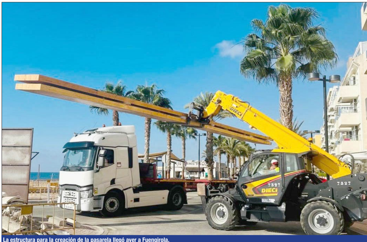
La estructura para la creación de la pasarela llegó ayer a Fuengirola.
