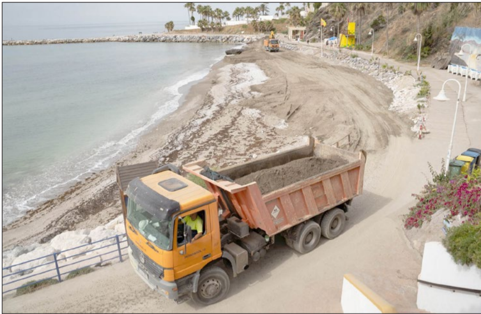
Trabajos de regeneración de playas.
